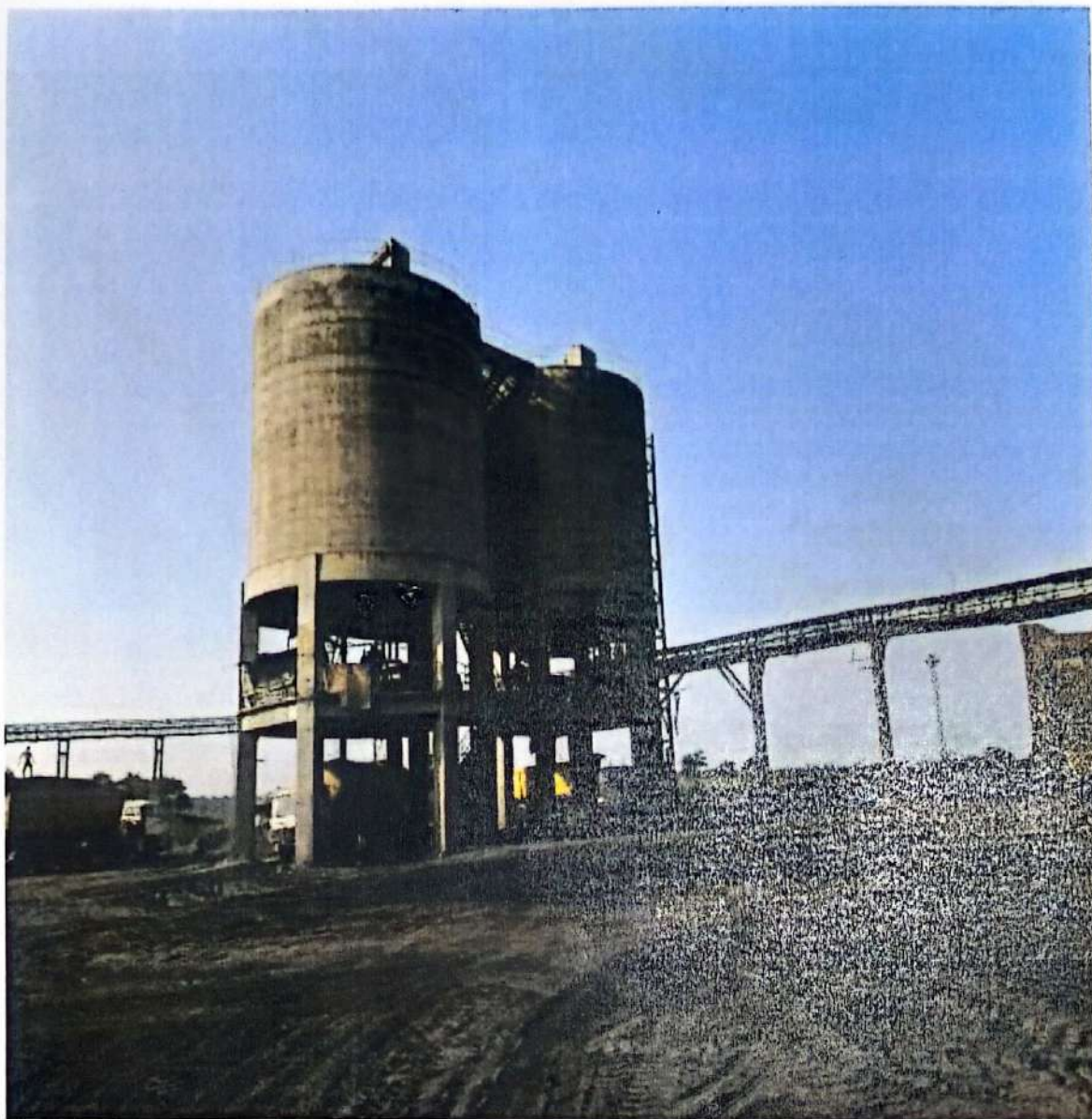
FLY ASH SILO
